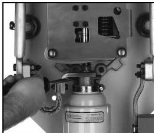
Рис. 12. Механическая проверка вакуума
